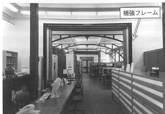
写真4 旧奈良県物産陳列所 耐震補強フレーム
