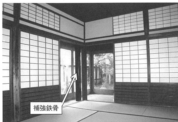
写真3 座敷の鉄骨による耐震補強
