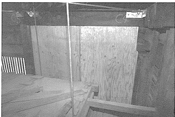
写真9 合板耐力壁補強
