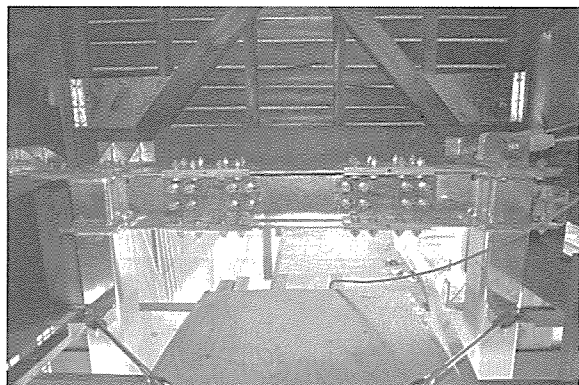
写真10 筋違金物補強・鉄骨フレーム上部
