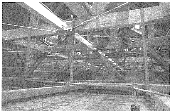
写真8 小屋裏ブレース補強
