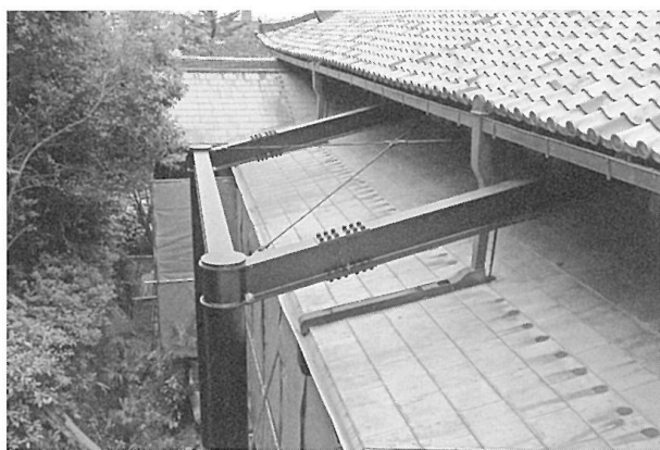
鉄骨バットレス補強
